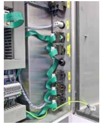
Auch die Verdrahtung der Bedienelemente ist einfach über SmartWire-DT möglich, eine grüne Lampe an jedem Teilnehmer zeigt die Betriebsbereitschaft an
