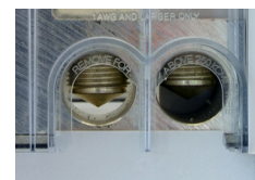
Terminales dobles en bloques de 600 A para facilitar el alambrado, usando dos cables de menor calibre.
