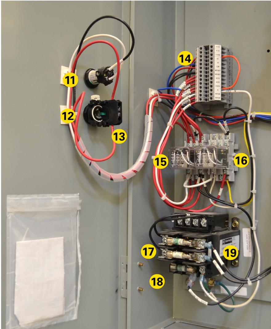
**Partes reemplazables en campo para Interruptor del Módulo de Alimentación**
